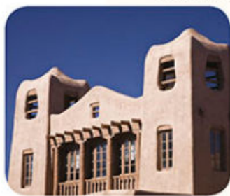
Figura 5.14. En algunas regiones se sigue utilizando el adobe como material de construcción.
