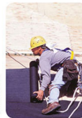
Figura 1.3. Hoy se usa una gran variedad de materiales que protegen las construcciones de los efectos del agua y del calor.
